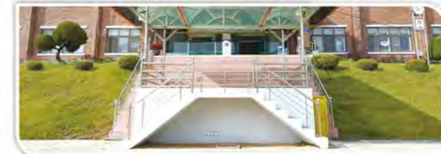
입석초등학교 안전난간대 설치
