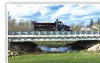
● 미국 아이오와에 건설한 Hawkeye Bridge(2015)
